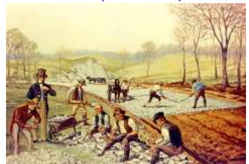
Строительство дороги Мак-Адамом
